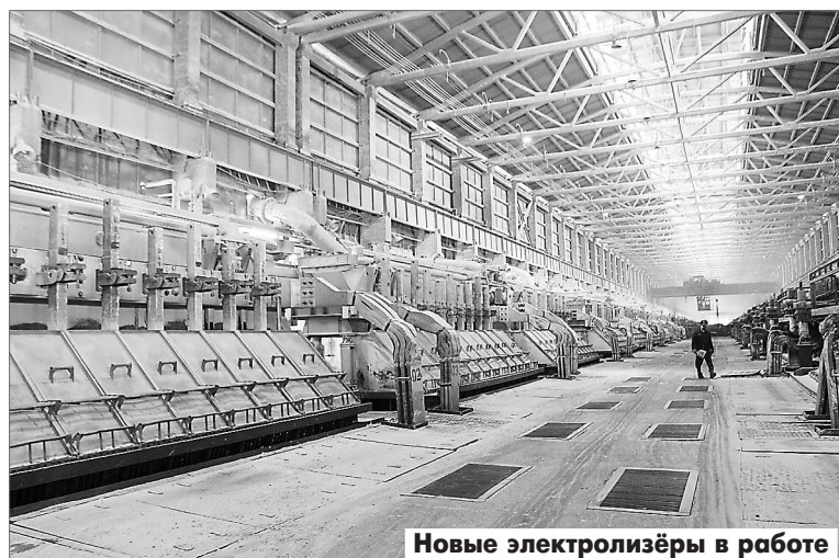
Новые электролизёры в работе
