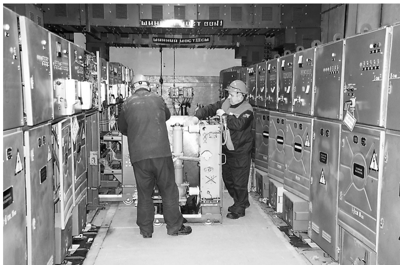
● Работы на опорной подстанции - 7 110/10 кВ (строительная площадка)
