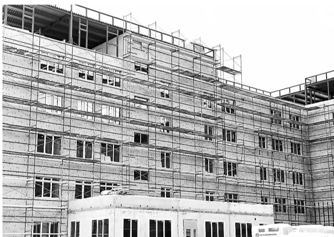
● Строится инфекционная больница
