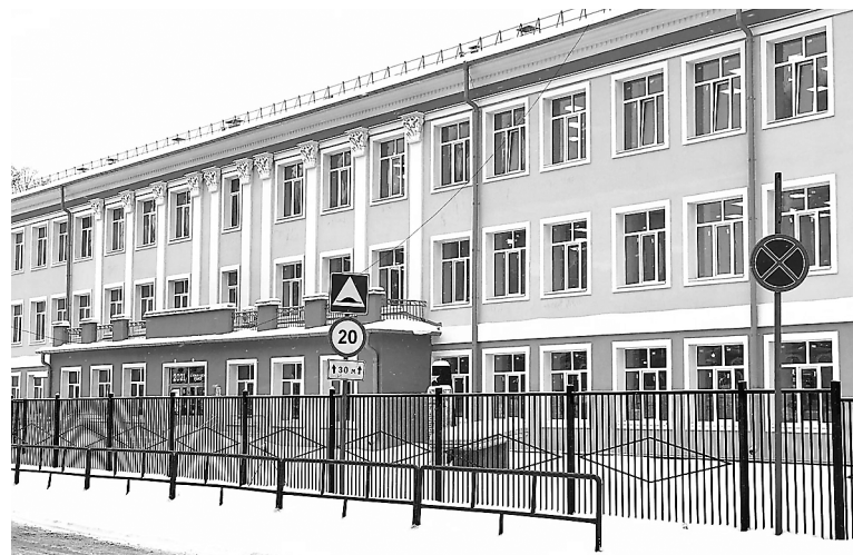
● Обновлённый вид школы №12 в Новокузнецке
