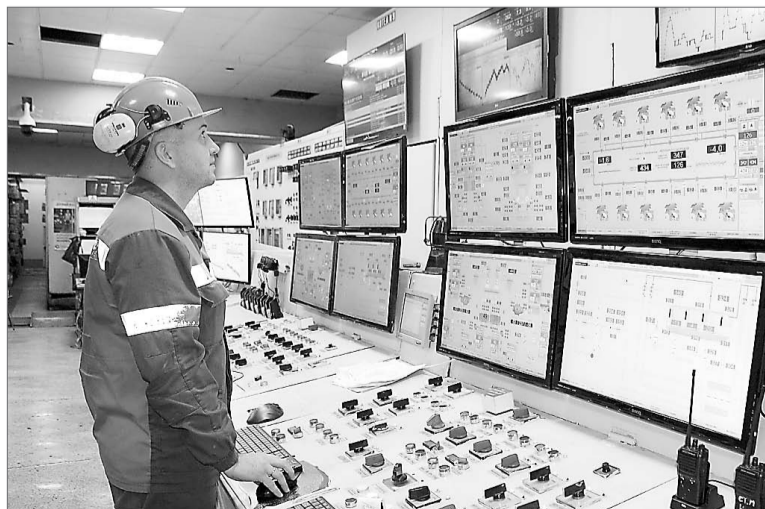
У центрального теплового щита – машинист Максим Балашов
